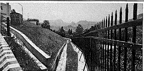
绿化及排水沟
