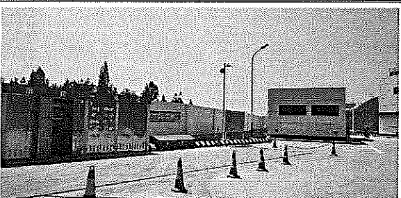
消防设施及卸油口
