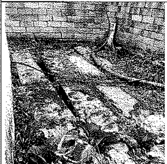
清镇沥青储备库化粪池
